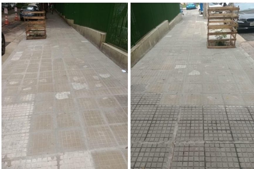
Imagem 2. Local do acidente após o reparo
