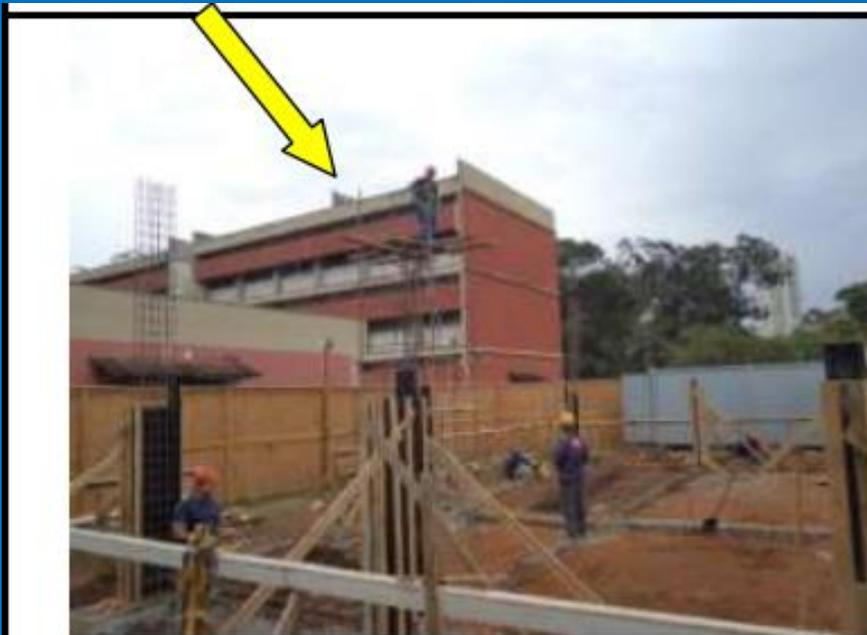
**Figura 1: Montagem de andaime sem ancoramento. O trabalhador não utilizava cinto de segurança, conforme preconizado na legislação vigente (NR-35).**
