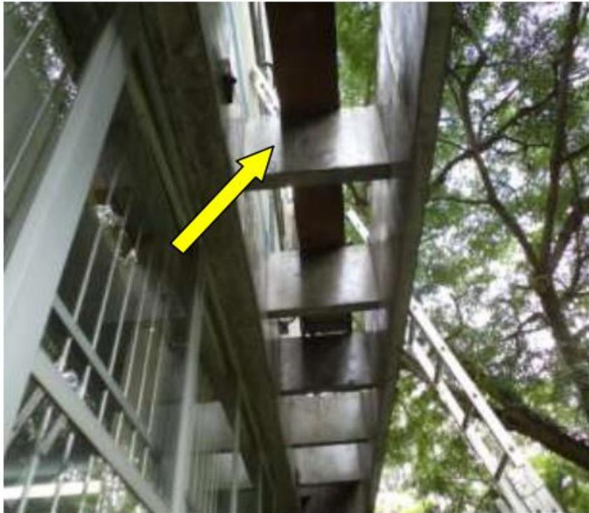
**Figura 1:** Para alcançar o local os trabalhadores utilizavam duas escadas, que não estavam ancoradas. Uma das escadas estava sobre prancha de madeira, podendo escorregar e ocasionar um acidente.
