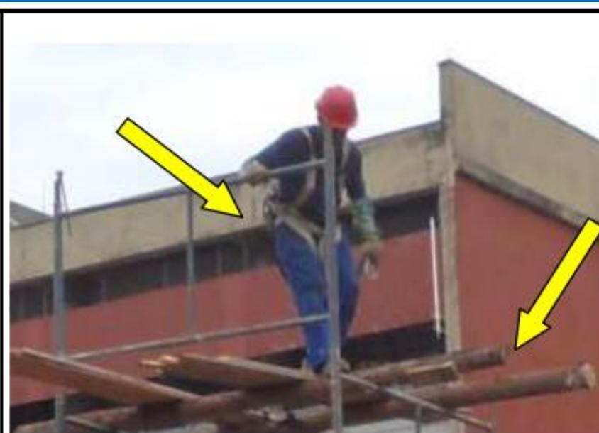
**Figura 2: Detalhe da improvisação do piso e trabalhador sem proteção.**
