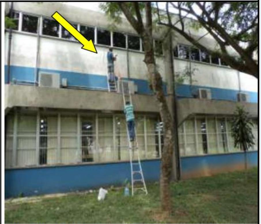
**Figura 2:** O cinto de segurança que um dos trabalhadores usava é de talabarte simples (não adequado) e o outro trabalhador não utilizava nenhum equipamento de segurança.
